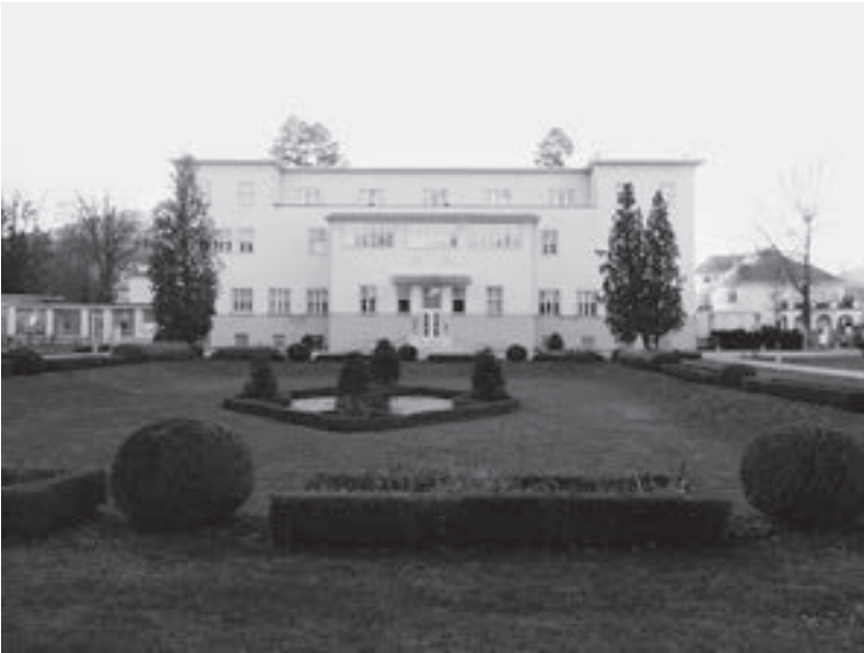
14. Josef Hoffmann, Purkersdorf Sanatorium, 1904
